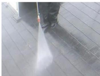
接着不良をさけるため、屋根材表面を高圧洗浄します。(圧力は目安10MPa(100kgf/cm<sup>2</sup>)前後)
