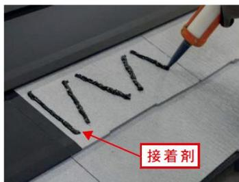
リコロニー専用開発された接着剤を、屋根材の全体に行き渡るよう八の字型に塗布します。
